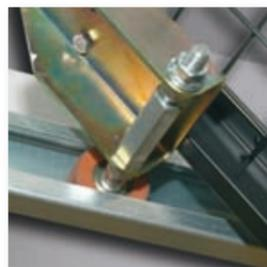
Pour assurer les mouvements fluides et réguliers, son tablier est guidé dans des rails verticaux et horizontaux à l'aide de 4 galets à billes surmoulés en polyuréthane.
